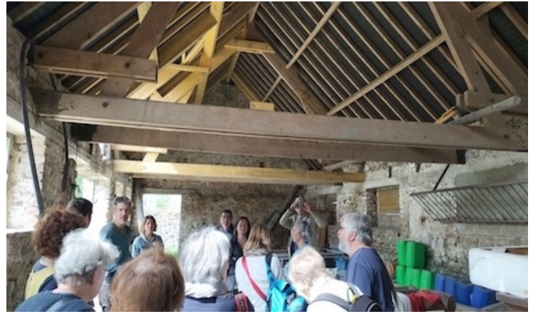
Intérieur de l'étable : futurs ateliers collectifs et individuels
