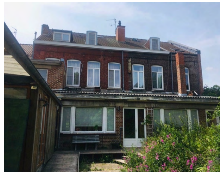
Le bâtiment principal
